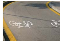
Manutenzione della segnaletica orizzontale in via Balestrieri
