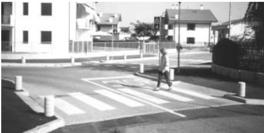
**Esempio di moderazione del traffico ottenuto con allargamento dei marciapiedi, restringimento della strada e cambio della pavimentazione**
