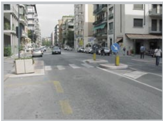
> Avanzamento marciapiedi: Via IV Novembre, Verona
