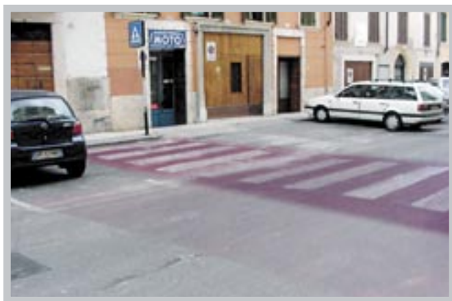
> Attraversamento pedonale colorato: Via Filippini, Verona
