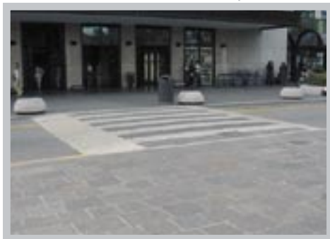
> Attraversamento rialzato: Stazione Porta Nuova, Verona
